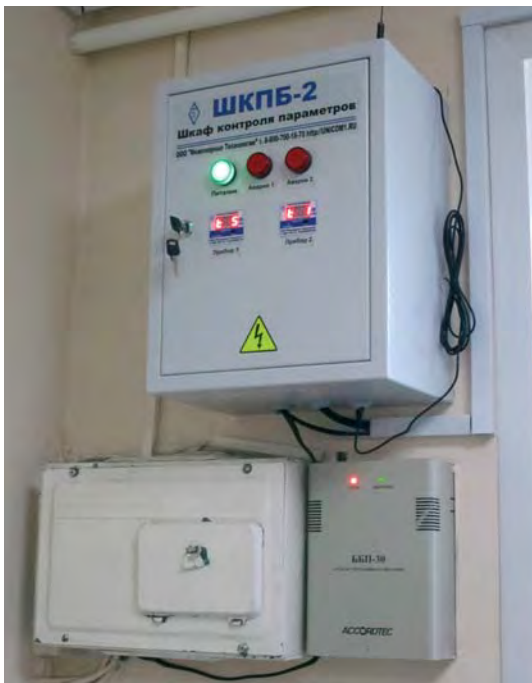
Рис. 4. Монтаж управляющего модуля системы контроля в складском помещении
